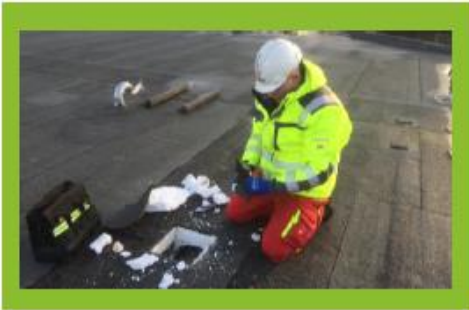
Ingangscontrole dakbedekking
